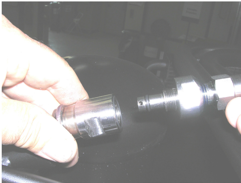
Figure 6 – Retrait de la partie mobile de la soupape de sécurité
